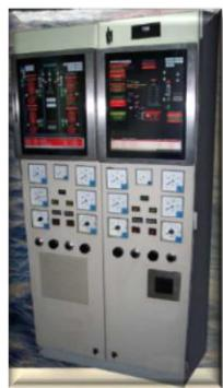
PDM (Panel Diesel Monitoring): Sistema instrumental de Control y Monitoreo, de Motores Diésel y Generadores en submarinos de fabricación alemana tipo 209, Armada de Chile, Armada del Ecuador, para permitir la carga de los bancos de baterías de la unidad.
